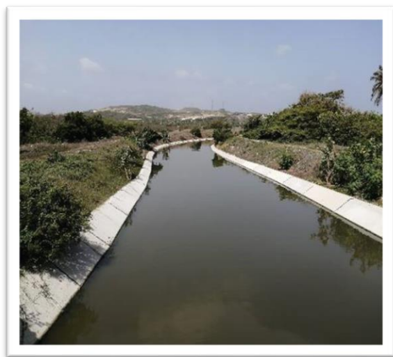
Canal de Bioremediación.
