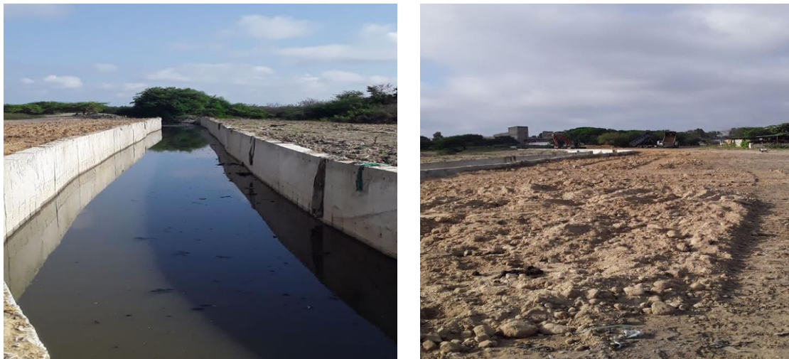
Figura 3.20 Obras de canalización arroyo El Salao.
