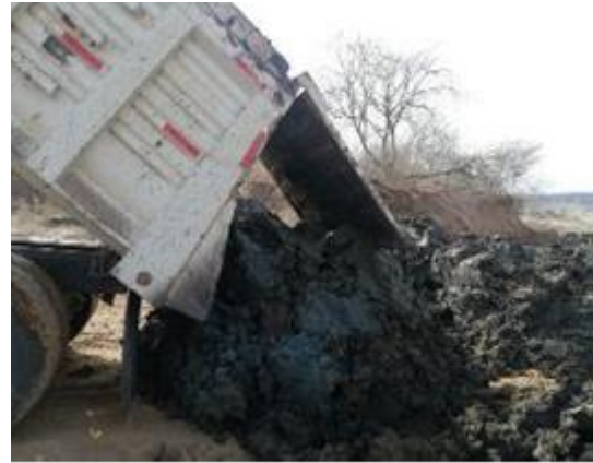
Figura 3.10 Actividades de retiro de sedimentos dragado del Embalse El Guájaro, Zona 5.
