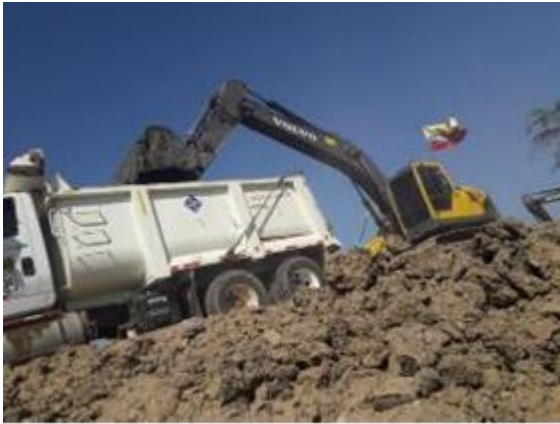
Figura 3.10 Actividades de retiro de sedimentos dragado del Embalse El Guájaro, Zona 5.
