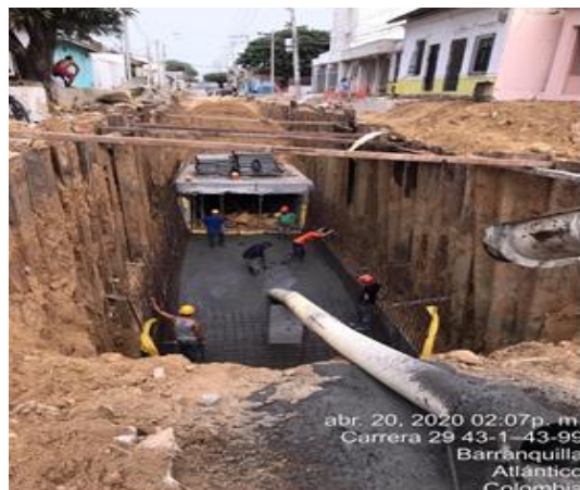
Figura 3.25 Reconstrucción vial y canalización del arroyo del Hospital.
