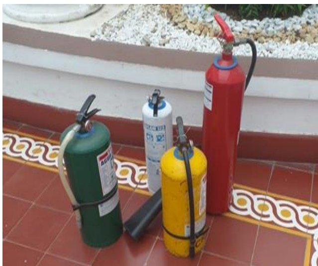
Figura 5.14 Extintores de la Corporación
