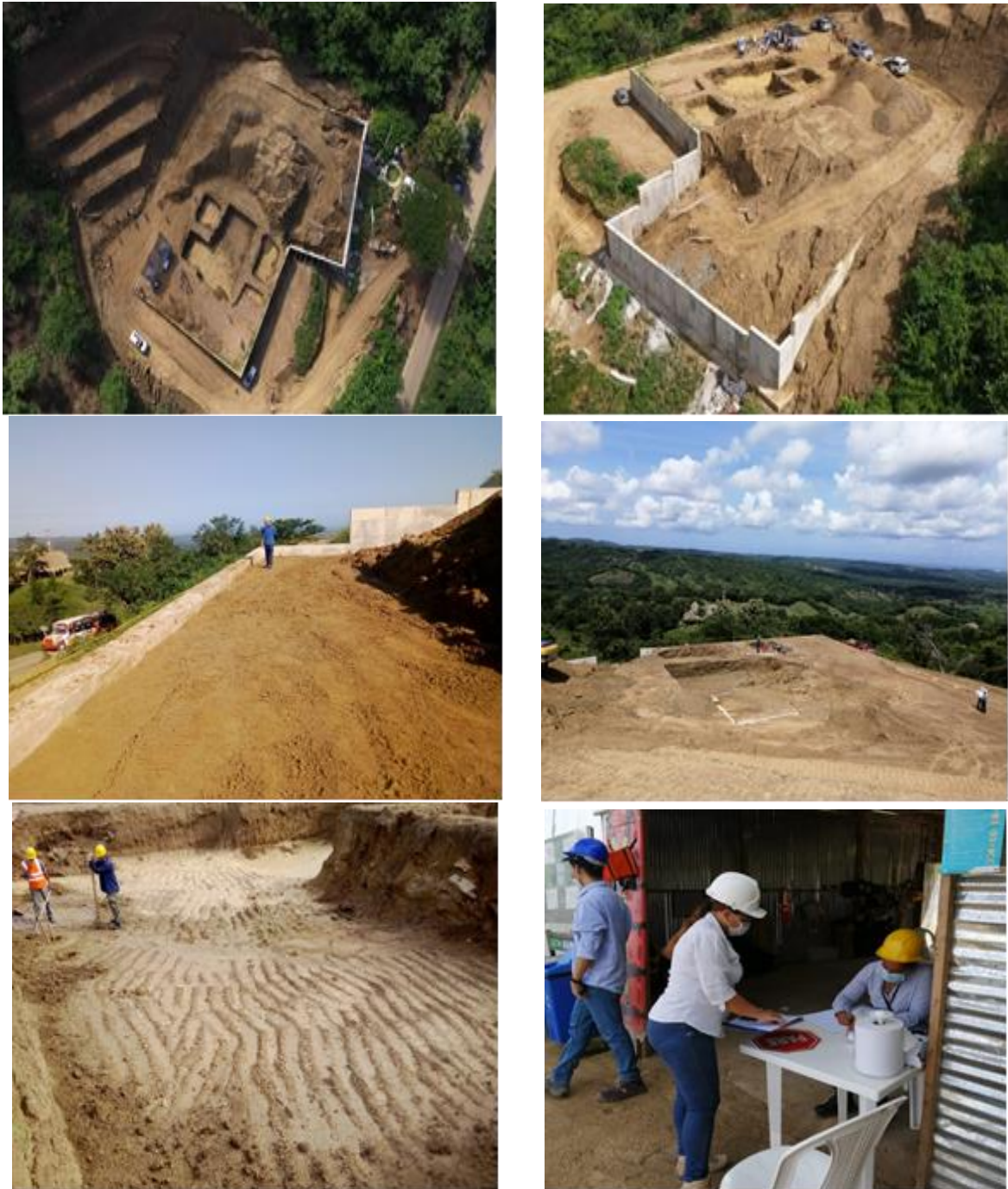
Figura 3.16 Obras de Construcción de la Planta de Tratamientos de Aguas residuales Municipio de Piojó.
