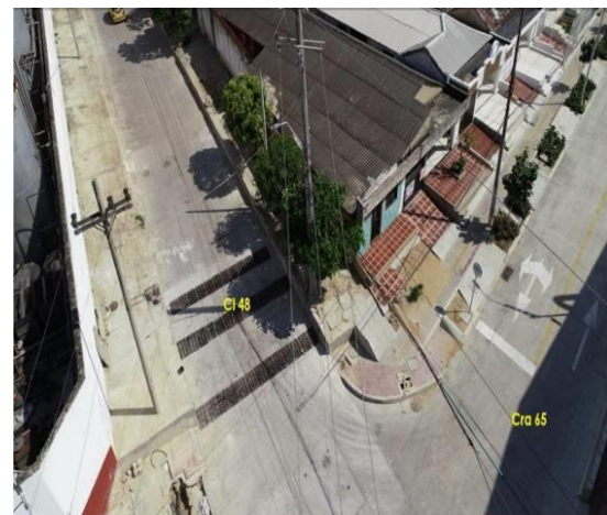
Figura 3.24 Reconstrucción vial y canalización del arroyo la Carrera 65.
